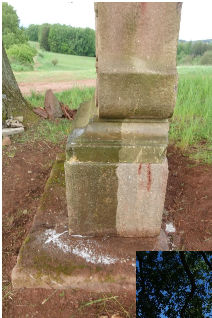
Obr 21, 22 a 23: Detail zkoušky čištění na levé straně podstavce. Celkový pohled na stav po prvním oplachu a celkový pohled na stav po omytí.
