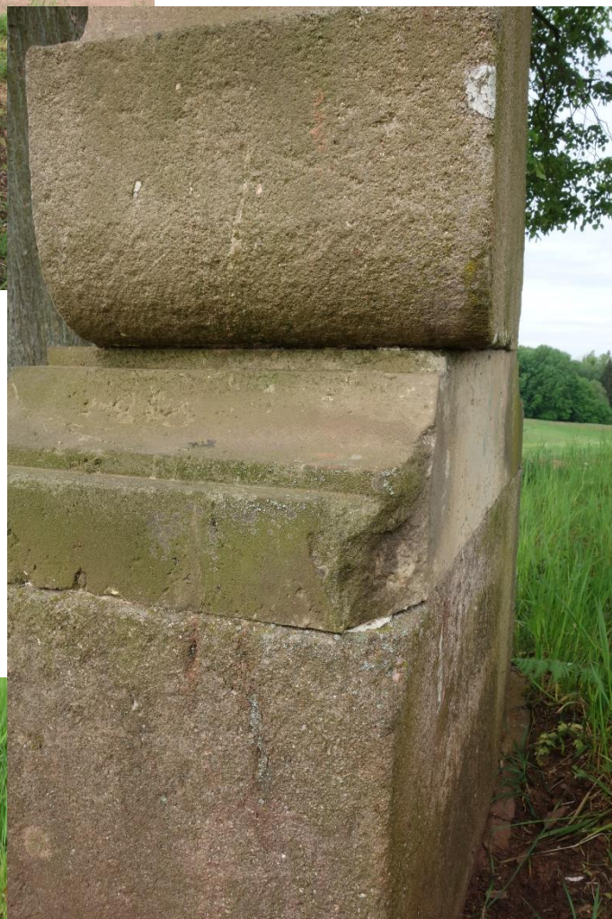
Obr: 8, 9 a 10: Stav před restaurováním. Detailní pohled na posunutí hlavice oproti soklu, pootočení soklu oproti podstavci a vychýleného levého stupně.
