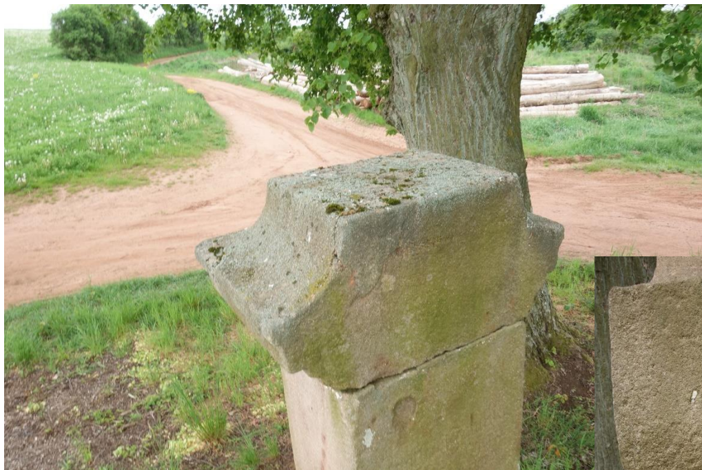
Obr: 8, 9 a 10: Stav před restaurováním. Detailní pohled na posunutí hlavice oproti soklu, pootočení soklu oproti podstavci a vychýleného levého stupně.
