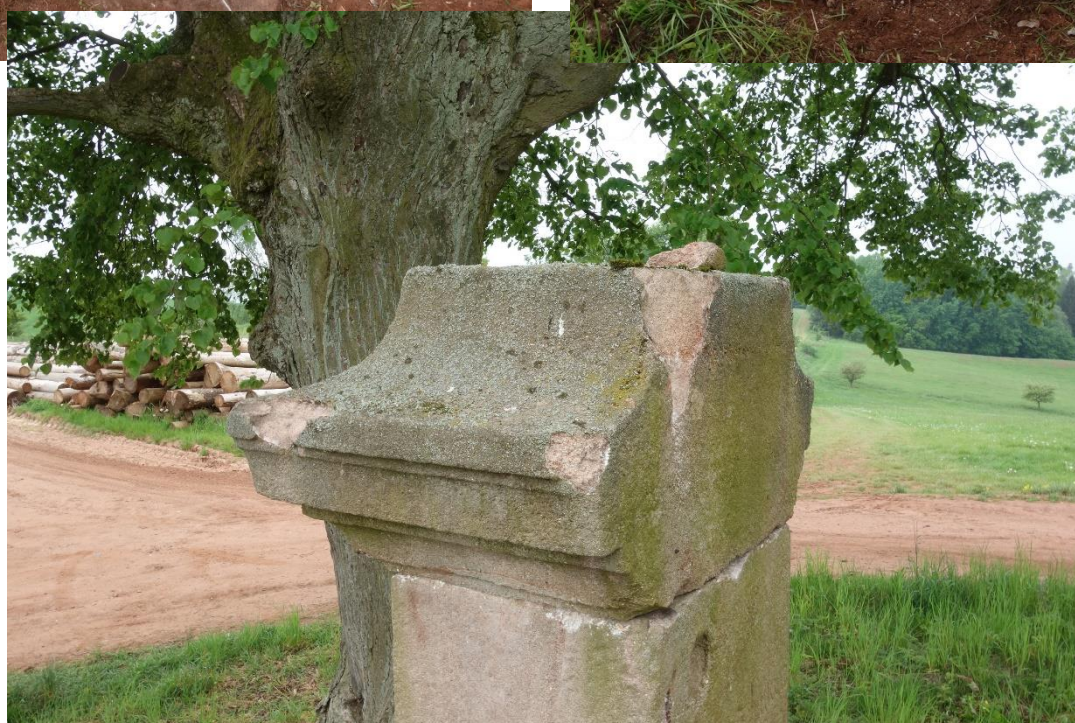
Obr. 18, 19 a 20: Stav po zarovnání pomníku a odstranění nevyhovujících vysprávek a vyčištění spár.
