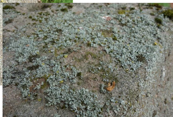
Obr. 6 a 7: Stav před restaurováním. Detail mechů a lišejníků na hlavici a otvoru po čepu kotvicím původní kříž.
