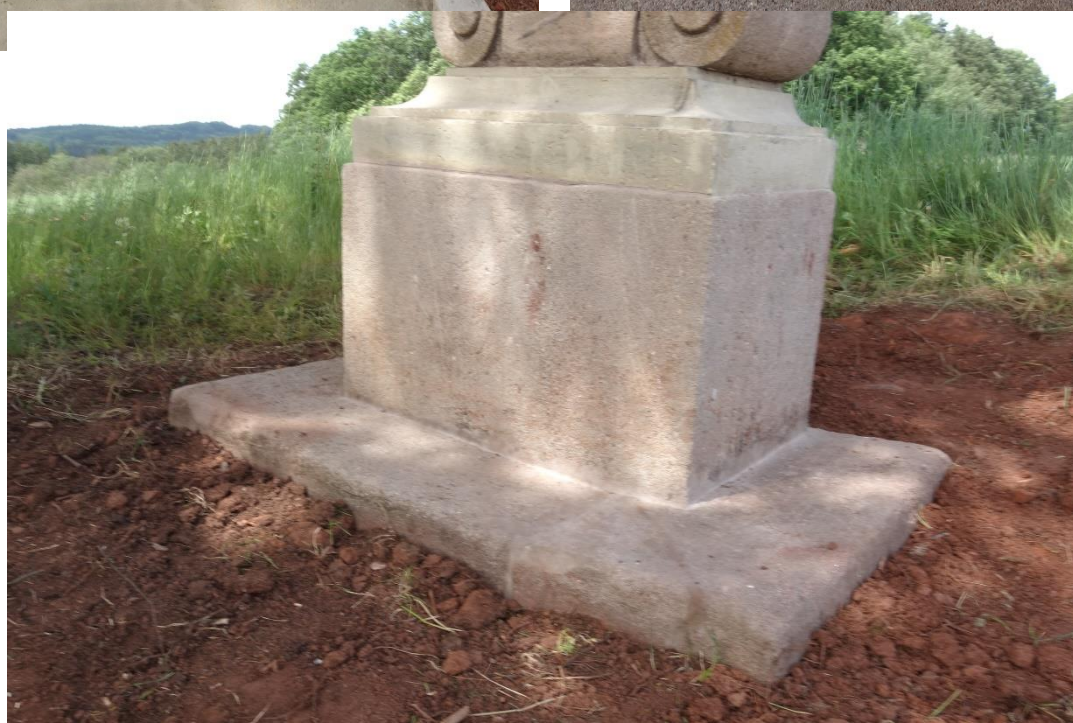
Obr. 30, 31 a 32: Stav po restaurování. Pohled zepředu soklu na sv. Kateřinu, zadní stranu soklu na text a stupu po kulové střele a srovnané stupně pod podstavcem a úpravu terénu.
