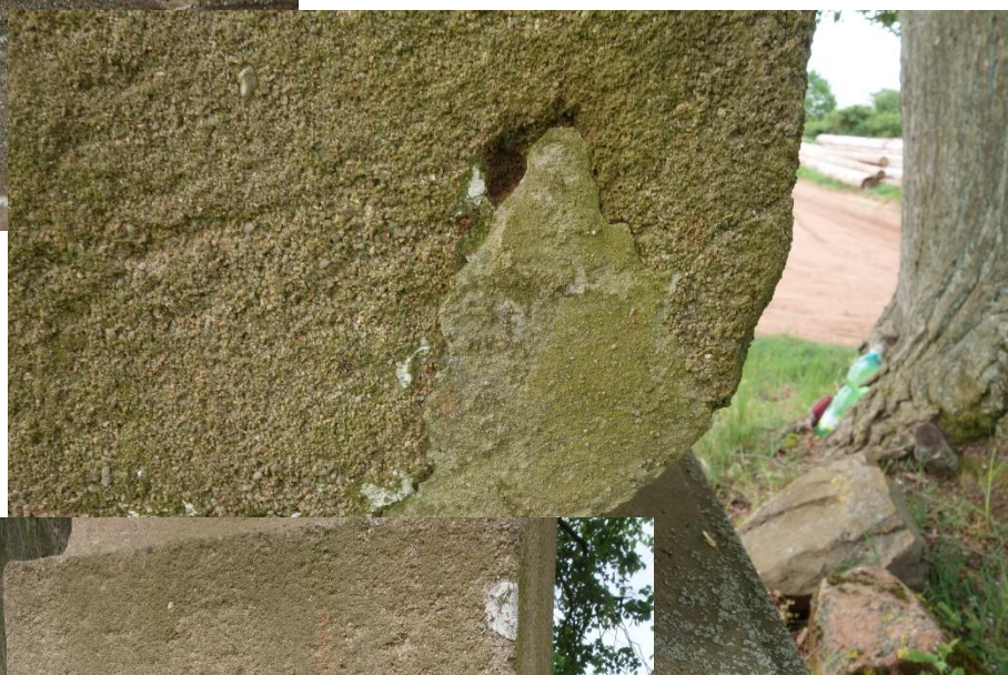
Obr. 11, 12, 13 a 14: Stav před restaurováním. Detaily poškození a nevyhovujících betonových vysprávek.
