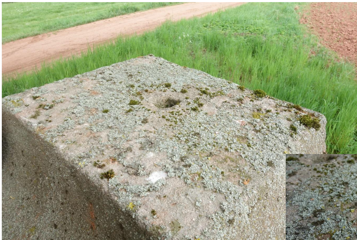
Obr. 6 a 7: Stav před restaurováním. Detail mechů a lišejníků na hlavici a otvoru po čepu kotvicím původní kříž.
