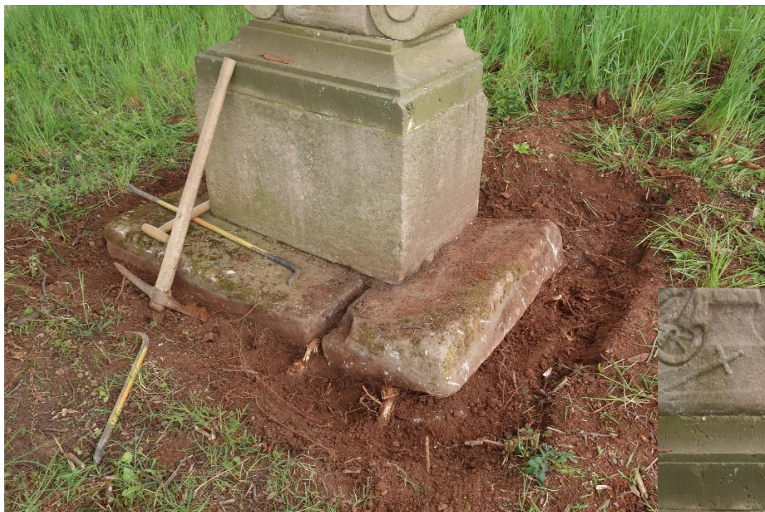
Obr. 15, 16 a 17: Obkopání pomníku, přizvednutí hřebenovým heverem a odstraňování kořenů.
