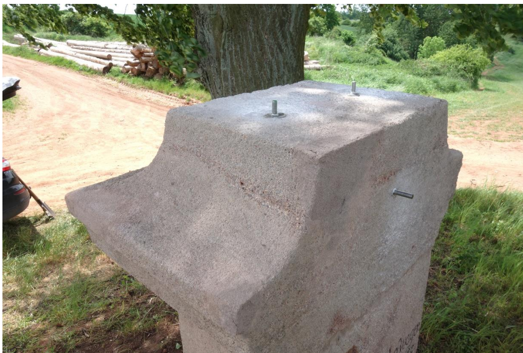
Obr. 27: Kotevní závitové tyče pro kovaný kříž.
