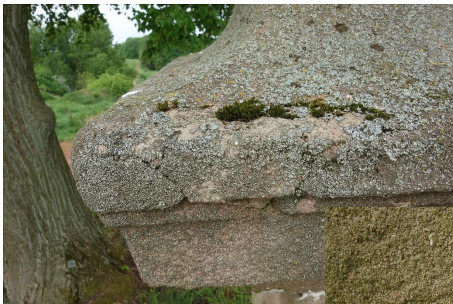
Obr. 11, 12, 13 a 14: Stav před restaurováním. Detaily poškození a nevyhovujících betonových vysprávek.
